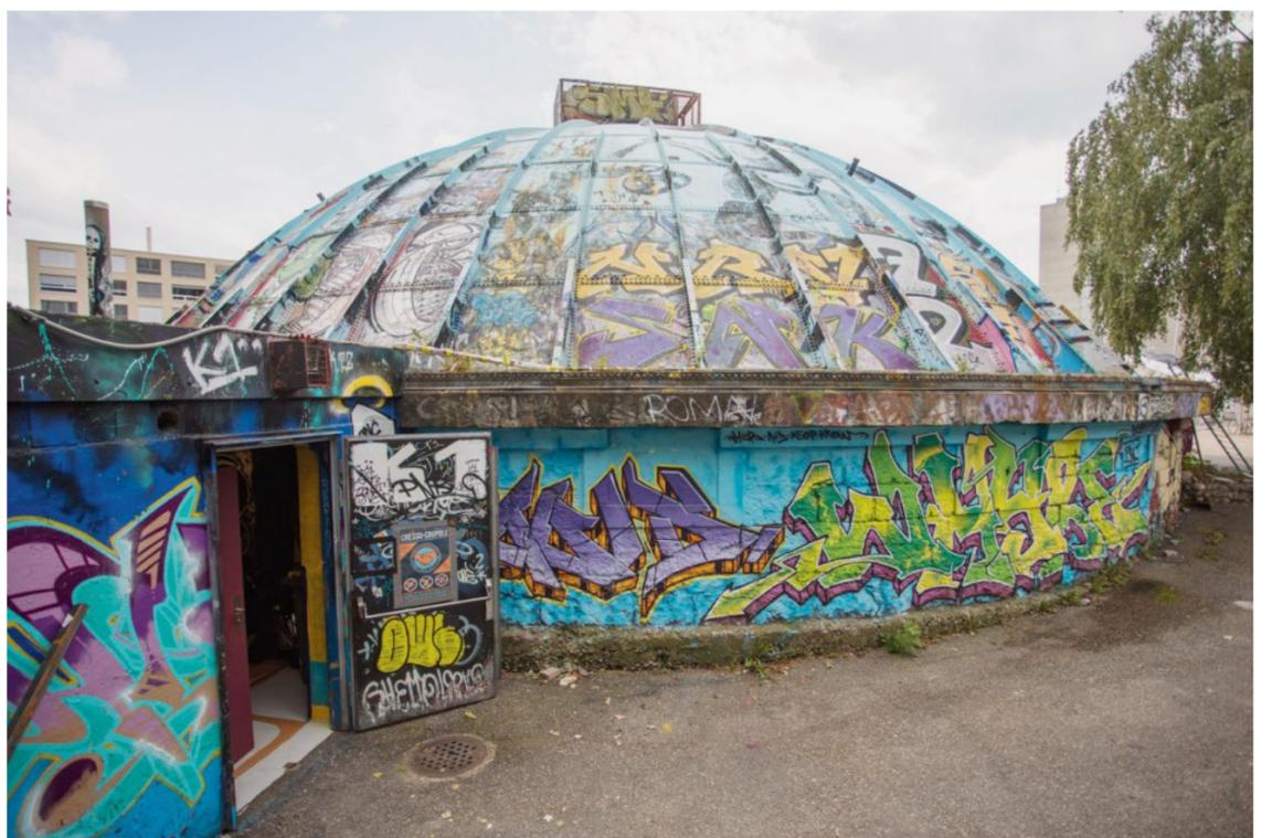
Der «Chessu» ist baufällig: Vor allem der Halbkranz-Anbau, in dem der Eingangsbereich, die Toiletten und Lagerräume untergebracht sind, befindet sich in einem schlechten Zustand. Frank Nordmann
